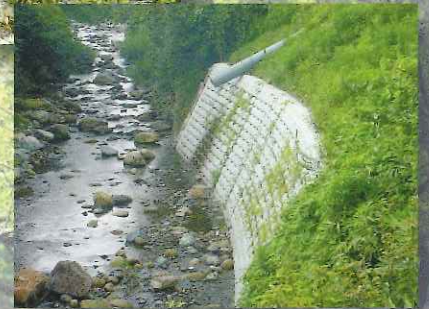
◆内住川 (福岡県 筑穂町)
