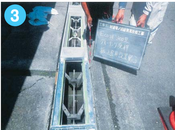
3 グレーチング受枠の設置
