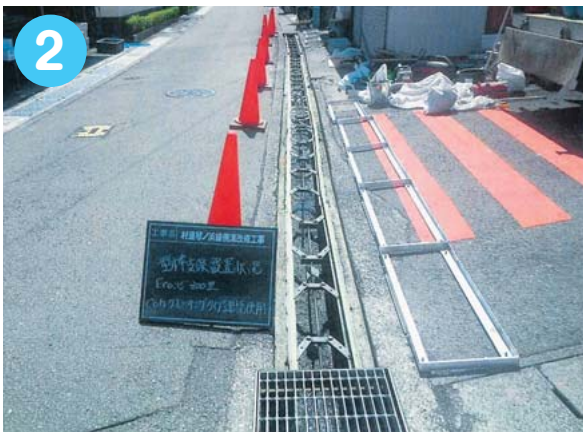
2 漏れ止め金具(支保工)の設置
