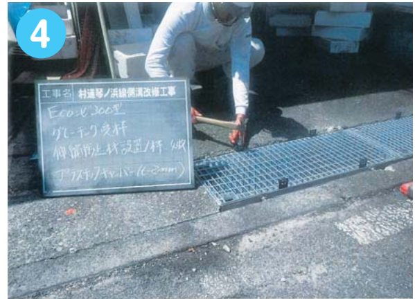
4 グレーチング本体の設置
