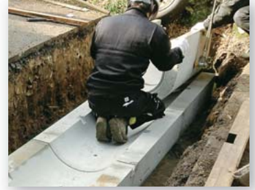
③ 側溝据え付け
