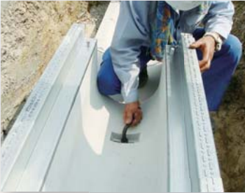
④ 固定ボルト締め
