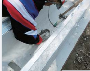
⑤ 連結部モルタル詰め
