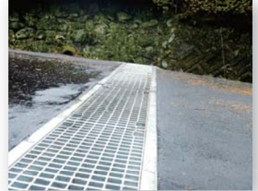
⑥ 舗装完成
