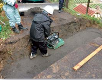
① 基礎材敷設
