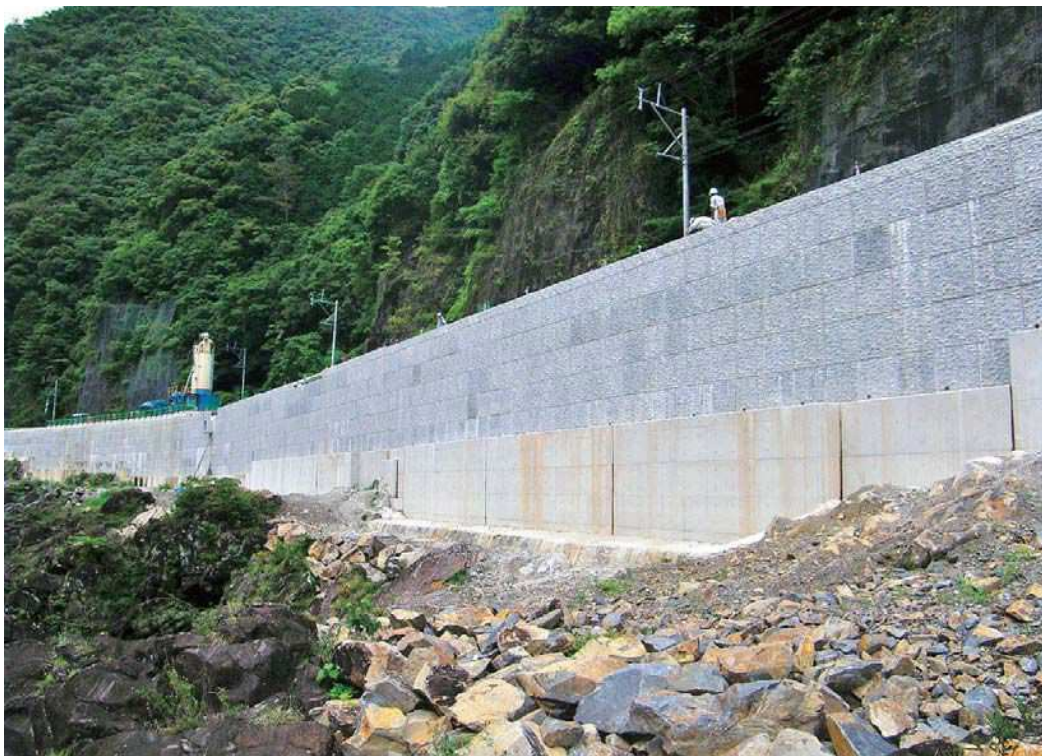
平成24年度国道219号十五番工区改良工事
