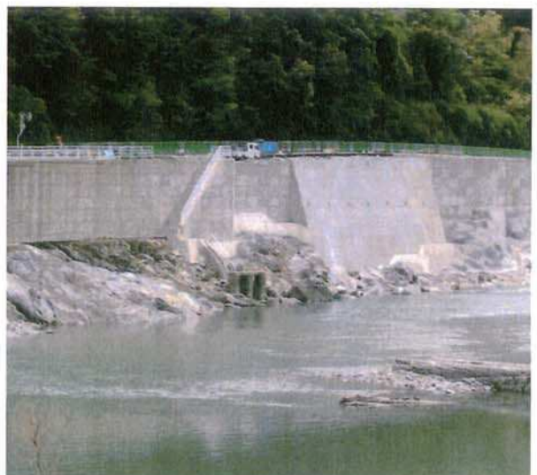
道路構築工法 (河川側拡幅)
