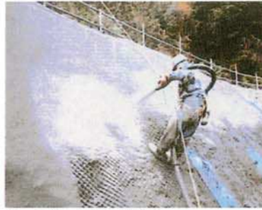
②エモルタル吹き付け工
