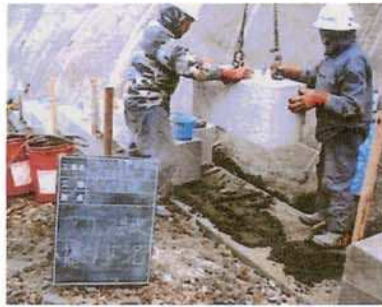
⑤基礎ブロック設置
