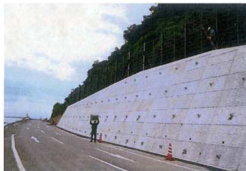
落石防護工法
