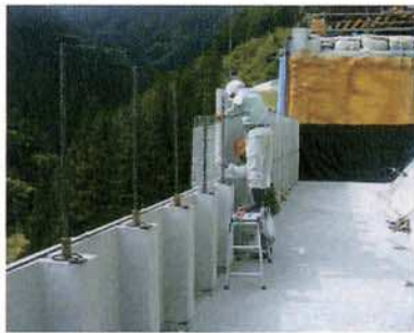
⑧N-S.P.Cパネル設置
