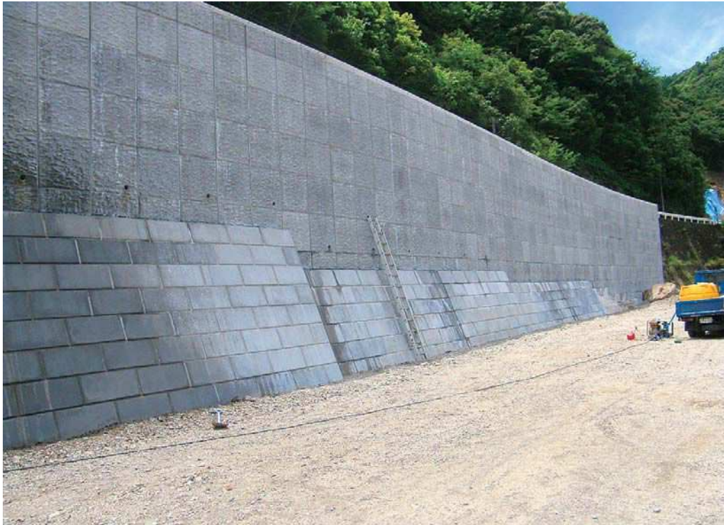
平成24年度一般国道503号八重工区改良工事
