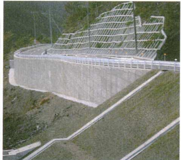
道路構築工法 (道路拡幅)
