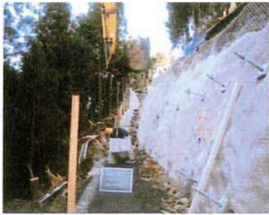
④平板式ロックボルト:吹付モルタル
