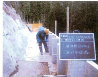
⑨補強プレート設置状況
