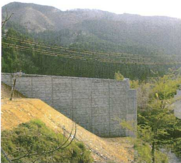
土圧軽減工法
