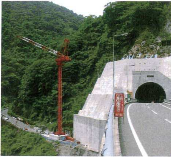
落石防護工法
