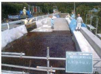
⑫瀝青剤散布状況
