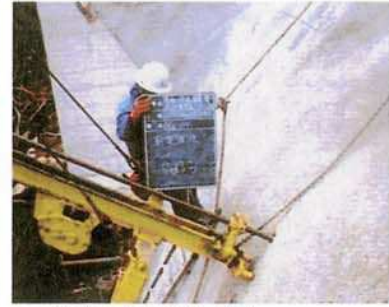
③平板式せん断ボルト削孔
