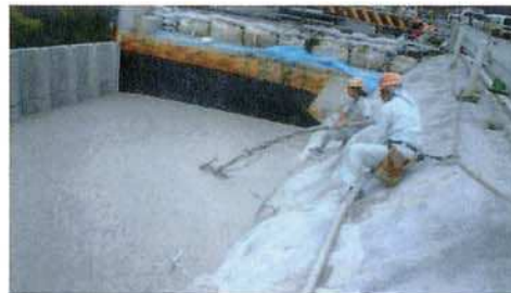
⑩気泡混合軽量盛土材打設状況
