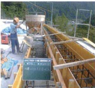
⑪地覆コンクリート打設状況
