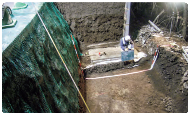
大型土のうによる接続部(一連の工程境)の処理
