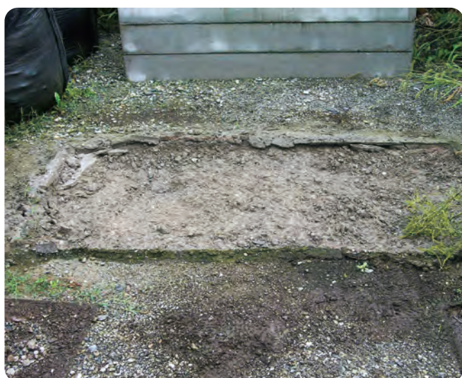
基礎版撤去後の基礎砕石
