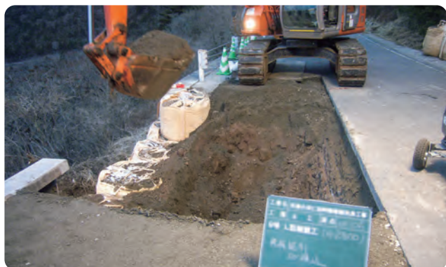
大型土のうによる接続部(一連の工程境)の処理
