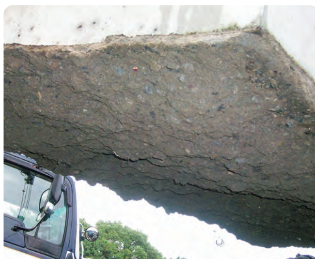
基礎版と敷きモルタルの一体化
